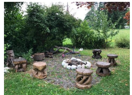
Der Ahornbaum musste der Baugrube weichen, der Stamm wird für Hocker für die Feuerstelle genutzt.
